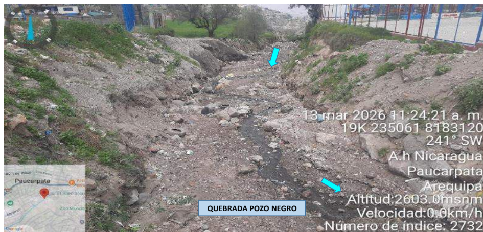
IMAGEN 01: SE OBSERVA EN EL TRAMO DE LA QUEBRADA POZO NEGRO, QUE SE ENCUENTRA SIN PROTECCIÓN EN AMBAS MARGENES, Y TAMBIEN SE OBSERVA QUE EL CAUCE SE ENCUENTRA COLMATADO DE PIEDRAS PEQUEÑAS Y SEDIMENTOS
