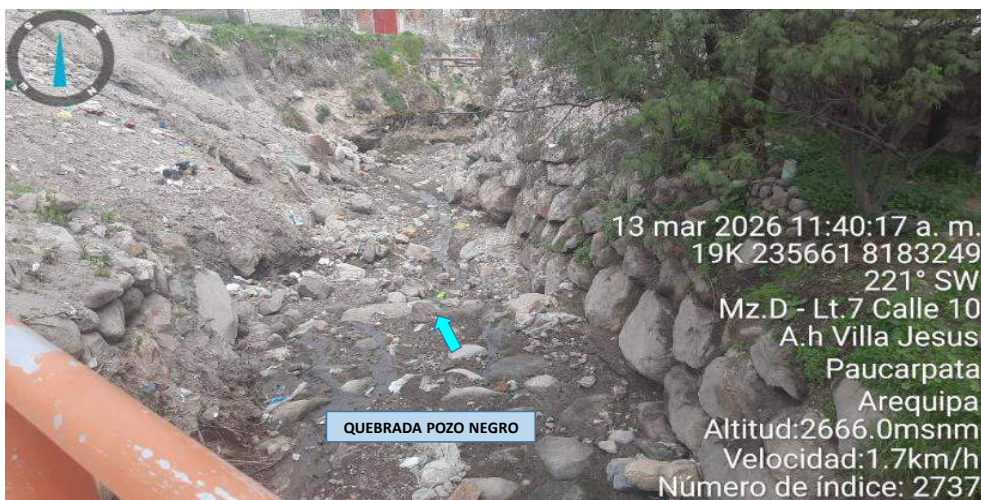
IMAGEN 02: EN ESTE TRAMO SE OBSERVA EN AMBAS MARGENES DE LA QUEBRADA POZO NEGRO, SE ENCUENTRA SIN PROTECCIÓN, Y SU CAUCE SE ENCUENTRA COLMATADO DE SEDIMENTO; Y EXISTEN VIVIENDAS CERCA A SU CAUCE.
