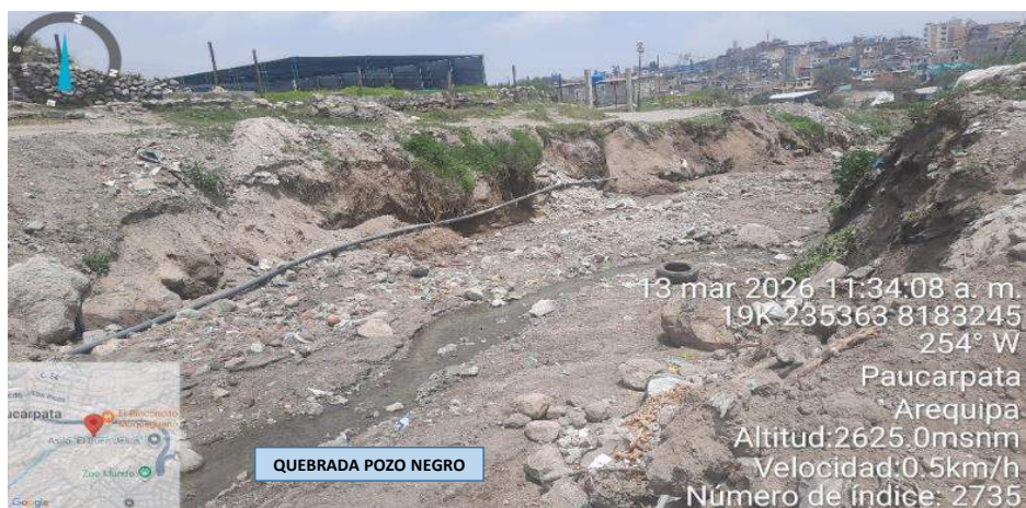
IMAGEN 03: EN ESTE TRAMO SE OBSERVA EN LA QUEBRADA POZO NEGRO, SU CAUCE SE ENCUENTRA COLMATADO DE SEDIMENTOS, Y SIN PROTECCION EN AMBAS MARGENES.
